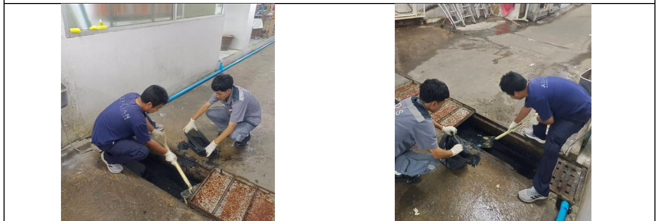
รูปที่ 2.2-31 ขุดลอกท่อระบายน้ำ
